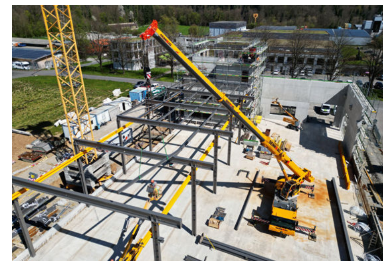
La halle a été réalisée sous forme de construction métallique.
