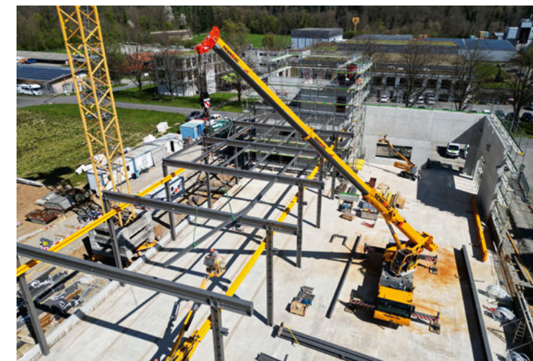
Die Halle wurde als Stahlbaukonstruktion ausgeführt.
